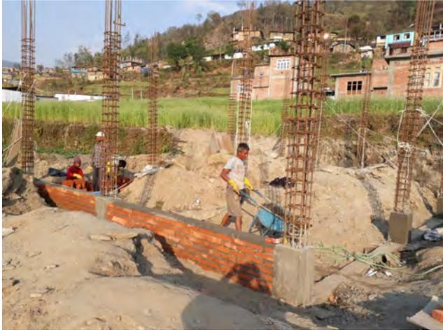
Besonders bei Fundament und Rahmenkonstruktion führte der Bauingenieur Anushesh Rayamajhi, der den gleichzeitigen Wiederaufbau der lokalen Sekundarschule beaufsichtigte, genaue Kontrollen durch, um die Erdbebensicherheit zu gewährleisten. 23 lokale Facharbeiter und ungelernete Arbeiter arbeiteten insgesamt 379 Personentage an dem Bau, wodurch gleichzeitig auch Einkommen für die lokale Bevölkerung geschaffen wurde.
